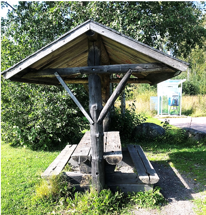
Skräpet är fördelat till sittbänken mot parkeringen.
